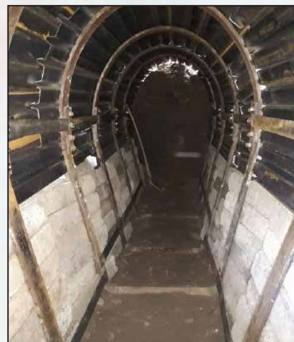
Část zpřístupněné chodby do podzemí vulkánu, zajištěné profitem typu „pražské rámy“
