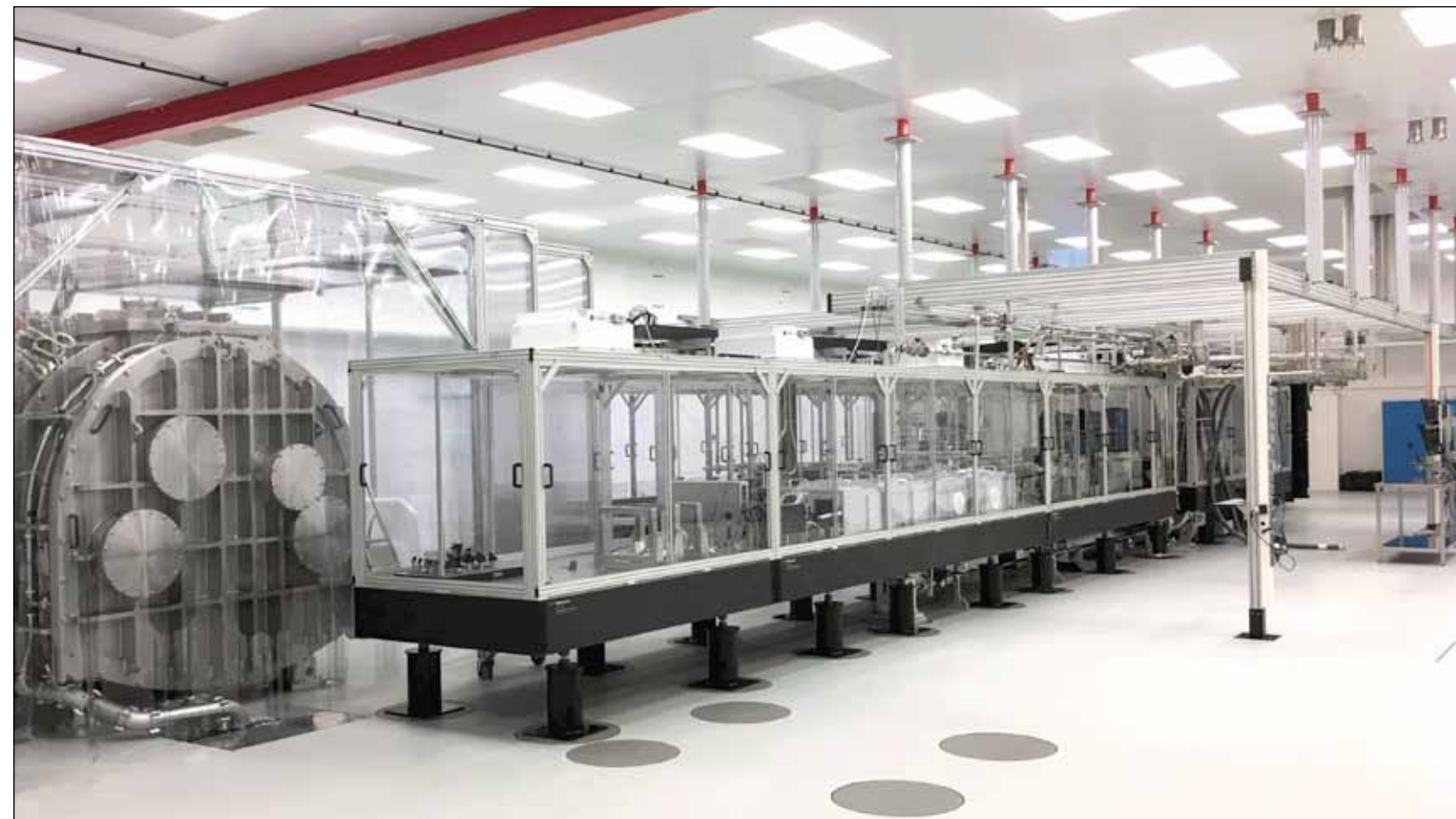
Laserový systém L3 při instalaci a spouštění
